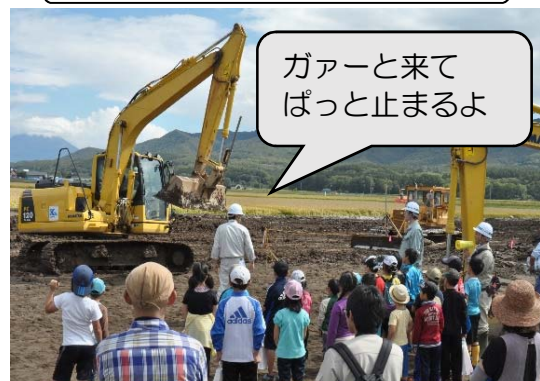
機械が動いている様子を見学
