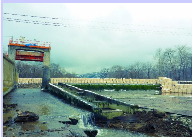
仮締切工大型土嚢
