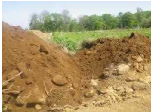
ダンプトラックに積み込み運搬状況
