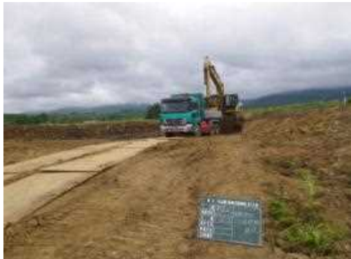
基盤整地後の浮石転圧処理状況
