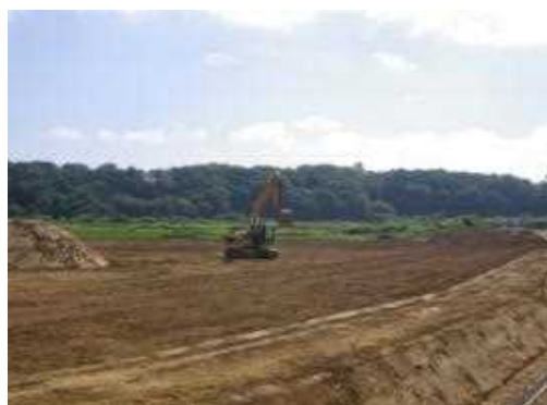
基盤整地後の浮石転圧処理状況
