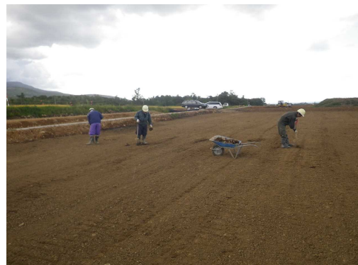
客土材混入している石を撤去状況
