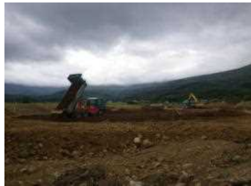
基盤整地後の浮石転圧処理状況
