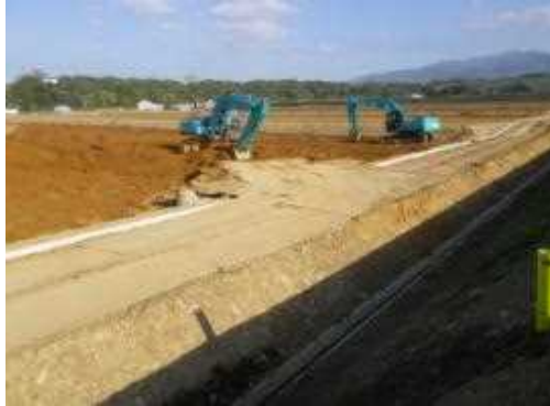
敷鉄板による、ほ場進入路の確保状況
