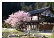
古民家等の改修
