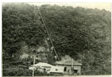
道内初の水力発電所（岩内町）
