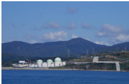
泊発電所全景
