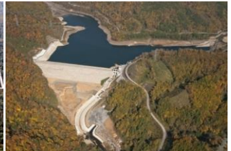
京極ダム全景
