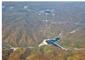
←京極発電所全景
