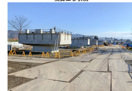
橋脚工事状況
