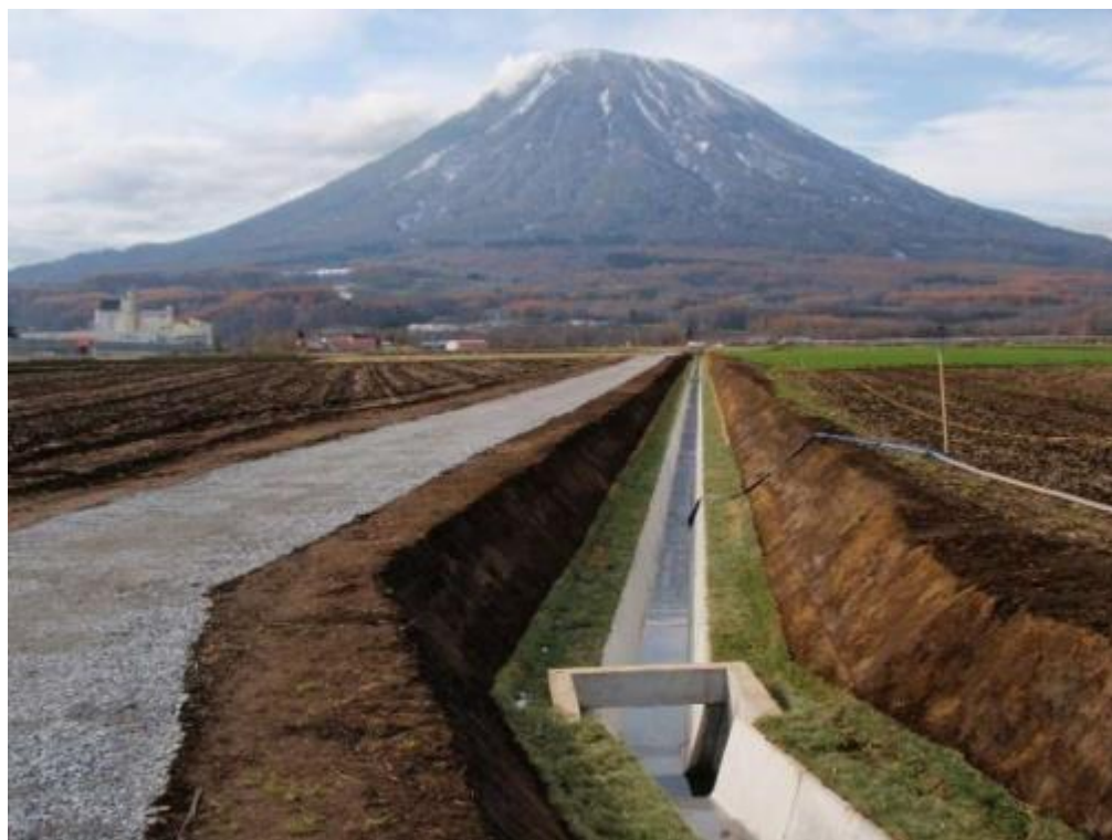
農業用排水路の整備
