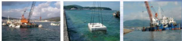
被覆ブロック据付状況
