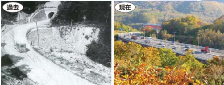
昭和9年 張碓トンネル 昭和6年着工・同8年竣工 一般国道5号
