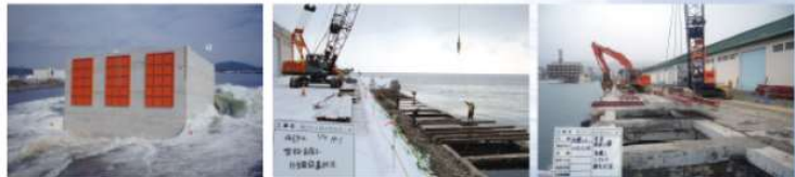
古平港用築造ケーソン進水状況
