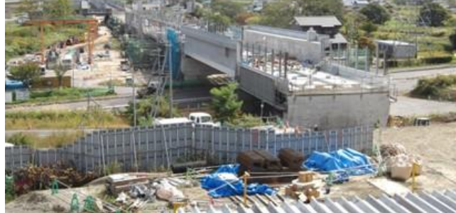
写真⑯ 市渡高架橋(北斗市)
