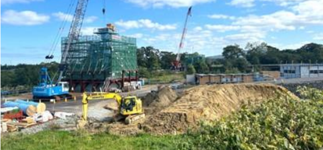
写真⑮ 大新高架橋(八雲町)
