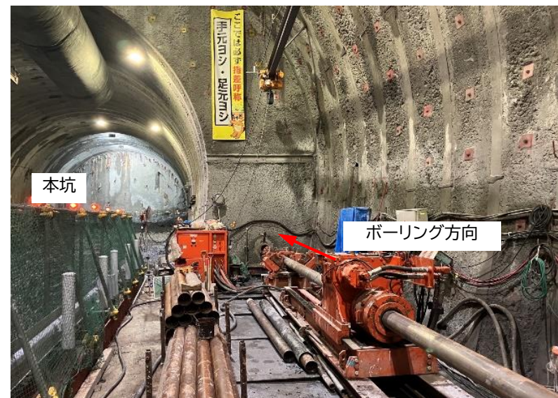
台場山工区ボーリング削孔状況
