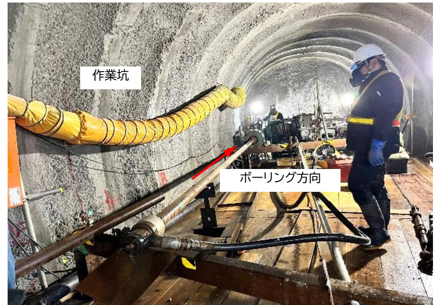
南鶉工区ボーリング削孔状況
