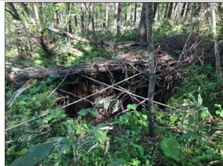
地表面陥没状況
