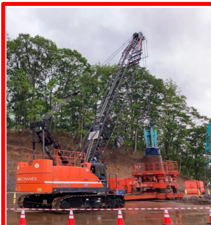
岩塊撤去状況
