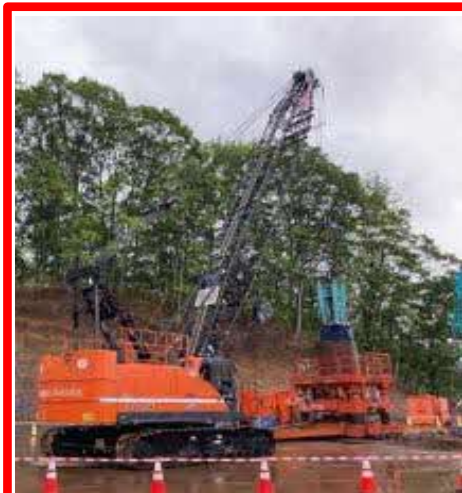
岩塊撤去状況
