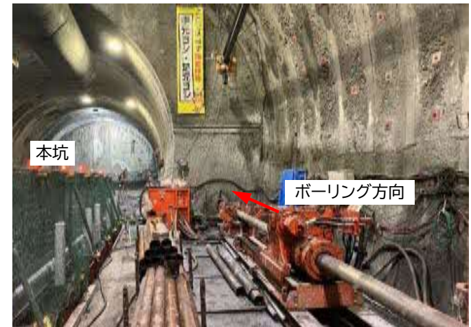
台場山工区ボーリング削孔状況
