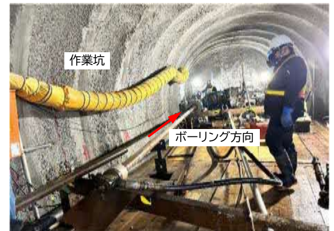
南鶉工区ボーリング削孔状況
