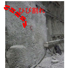
吹付けコンクリートのひび割れ
