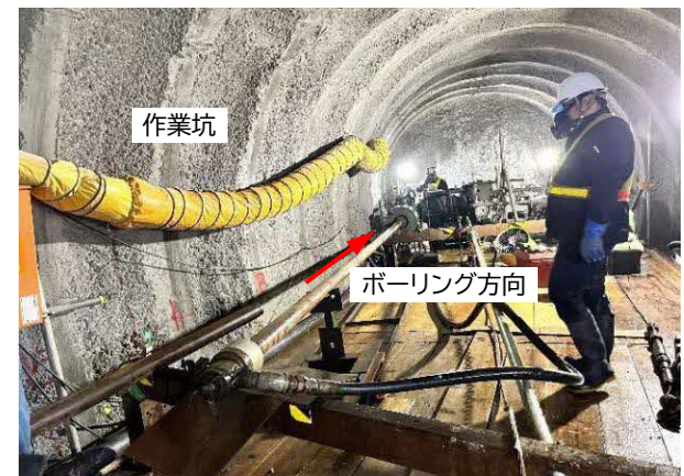
南鶉工区ボーリング削孔状況
