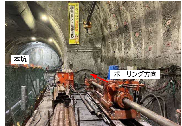
台場山工区ボーリング削孔状況
