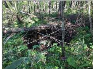
地表面陥没状況
