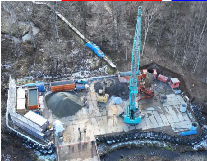
岩塊撤去状況
