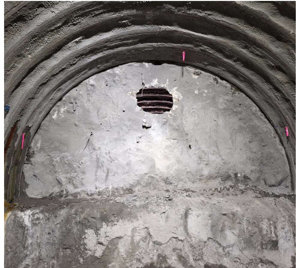
貫通点の状況
