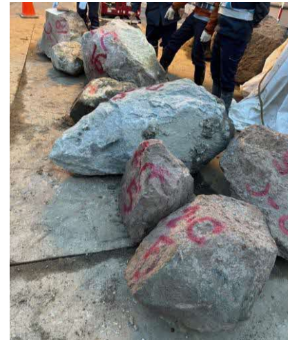
今回撤去した岩塊(長径最大約1.4m)
