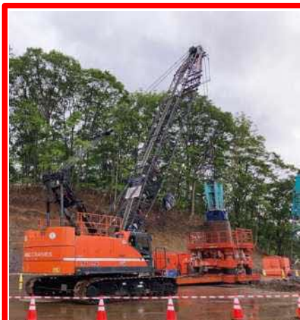
岩塊撤去状況
