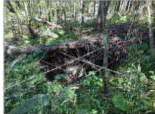
地表面陥没状況
