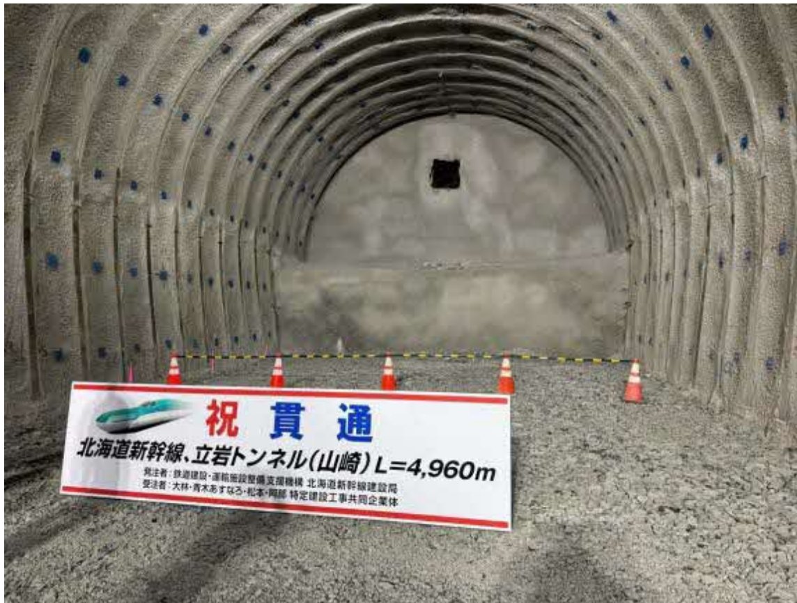
貫通点の状況
