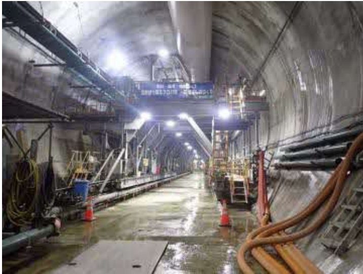
羊蹄トンネル(有島) 坑内状況
