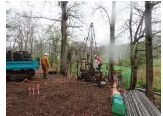
ボーリング調査状況
