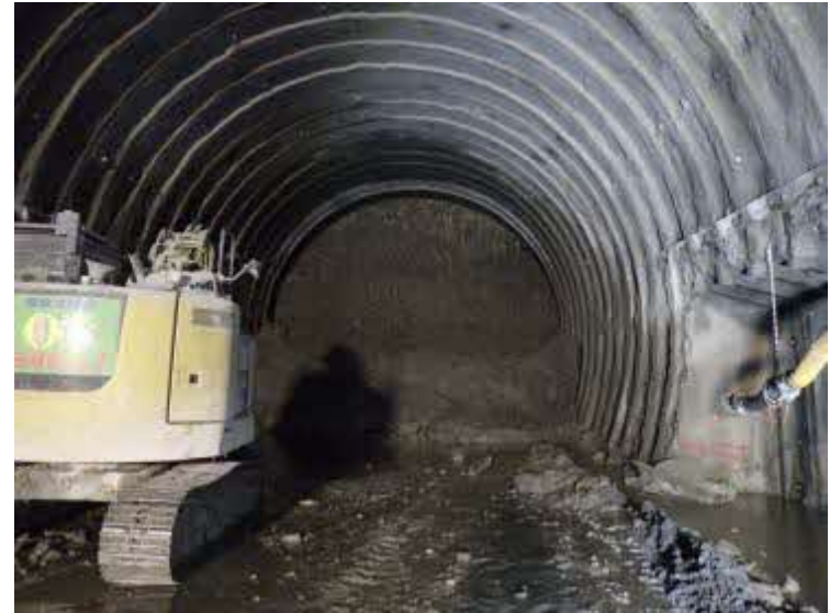
内浦トンネル(東川) トンネル掘削状況
