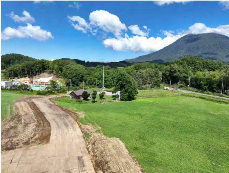
羊蹄トンネル(有島) マシン停止位置付近地上部
