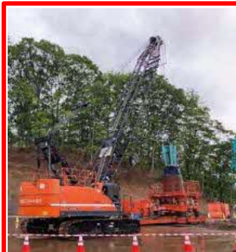
岩塊撤去状況
