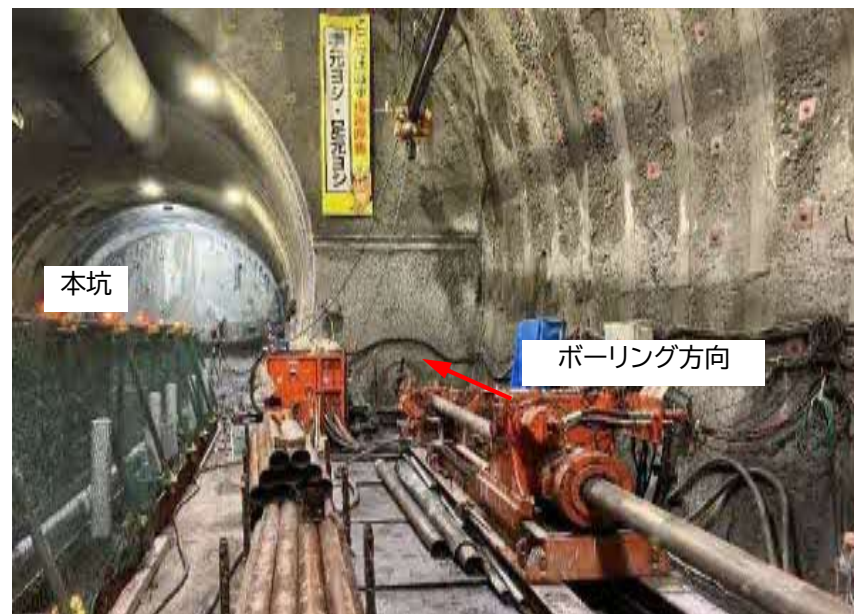
台場山工区ボーリング削孔状況
