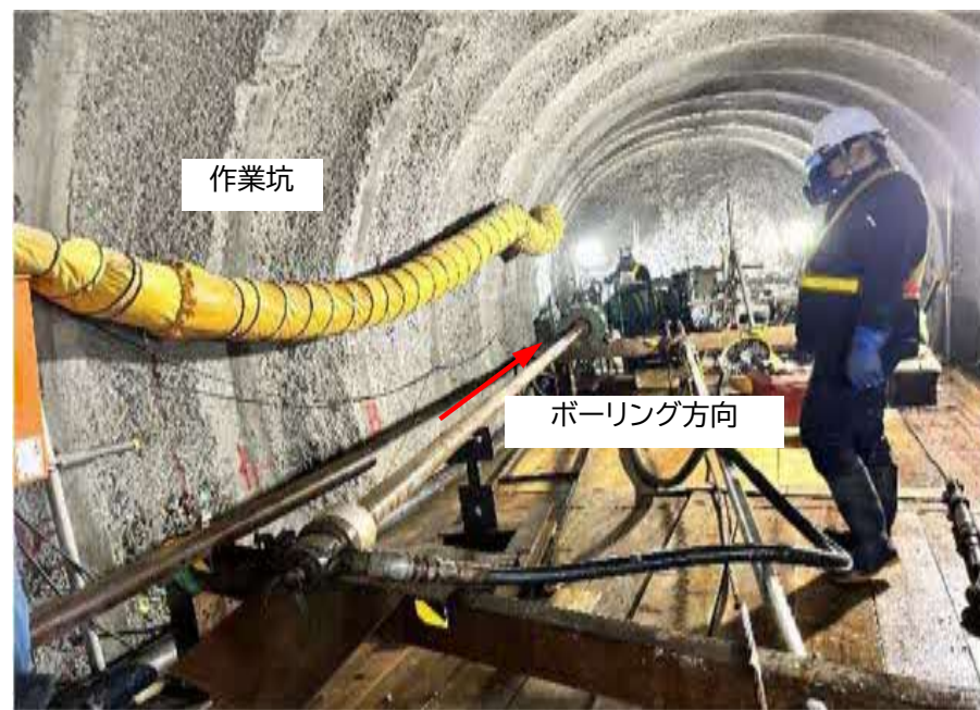
南鶉工区ボーリング削孔状況
