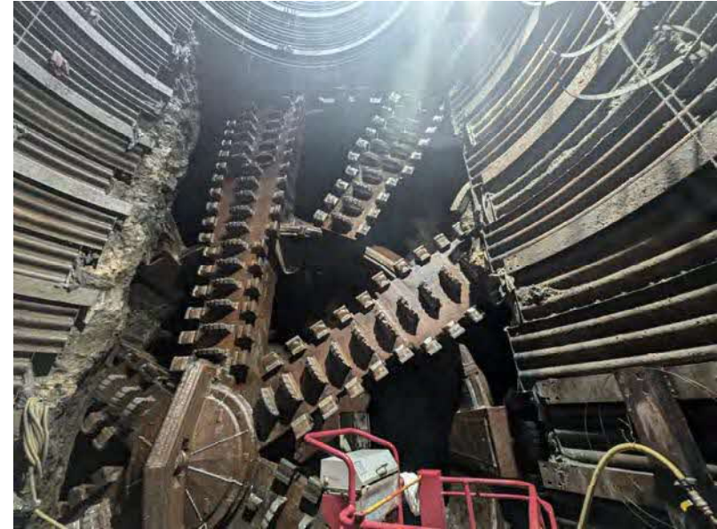
羊蹄トンネル(比羅夫) 中間立坑マシン面板
