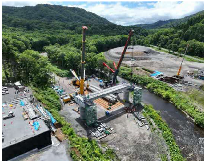
PCU形桁 架設状況
