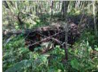
地表面陥没状況
