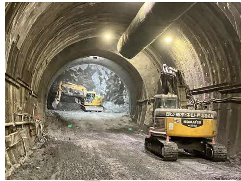
渡島トンネル(台場山) トンネル掘削状況
