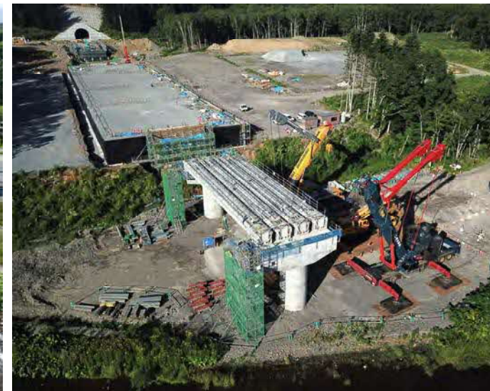
PCU形桁 架設状況
