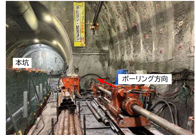
台場山工区ボーリング削孔状況
