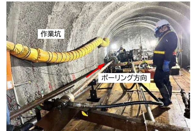
南鶉工区ボーリング削孔状況
