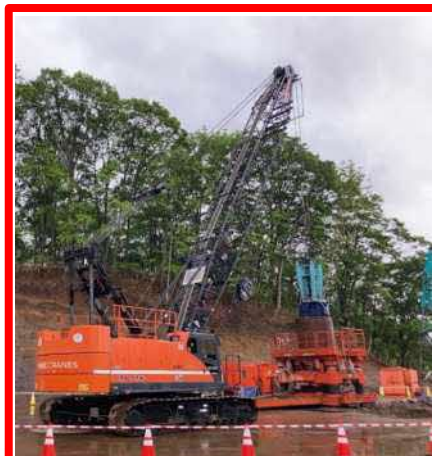
岩塊撤去状況
