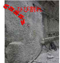
吹付けコンクリートのひび割れ
