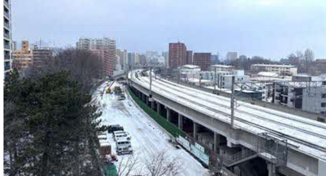
写真② 札幌トンネル桑園工区(札幌市)
