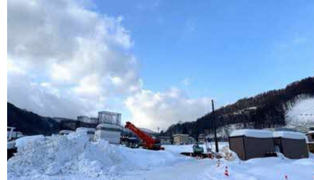
写真③ 新小樽(仮称)駅高架橋(小樽市)
