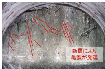
【特徴1】断層運動に伴う弱部の形成
