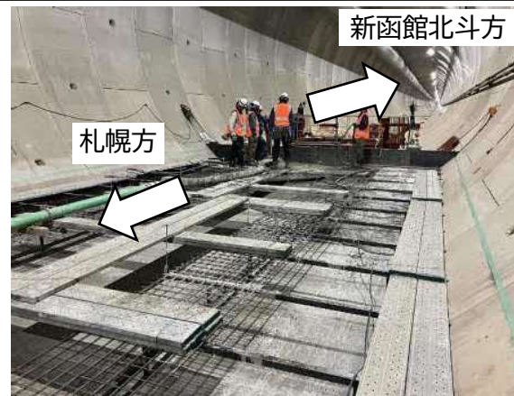
小樽方一次インバートコンクリート打設の様子
