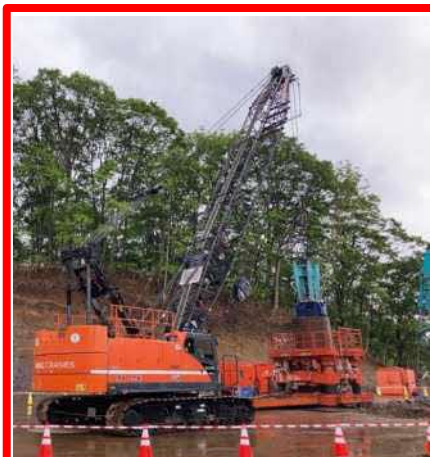
岩塊撤去状況
