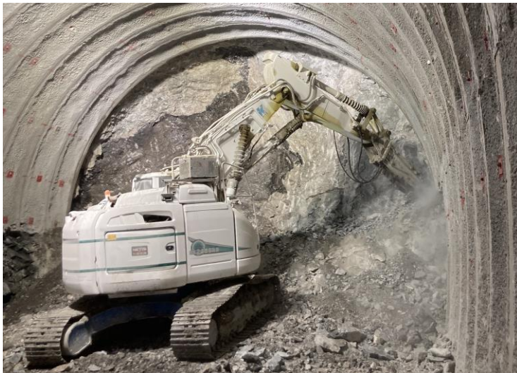
渡島トンネル(南鶉) トンネル掘削状況
