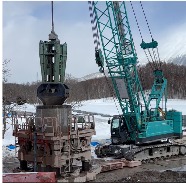
羊蹄トンネル(有島) マシン停止位置付近地上部岩塊撤去状況
