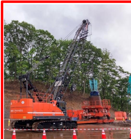
岩塊撤去状況
