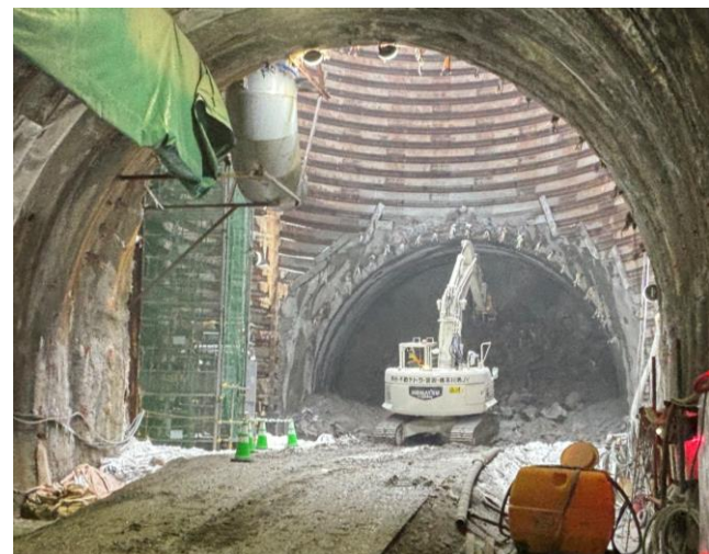
到達立坑からNATM掘削状況
