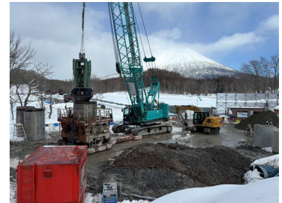
岩塊撤去状況
