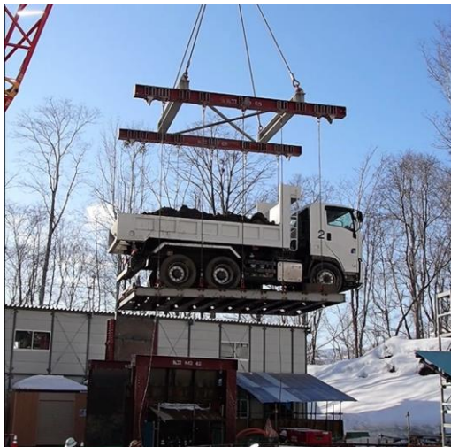
発生土搬出状況(到達立坑部(地上部))
