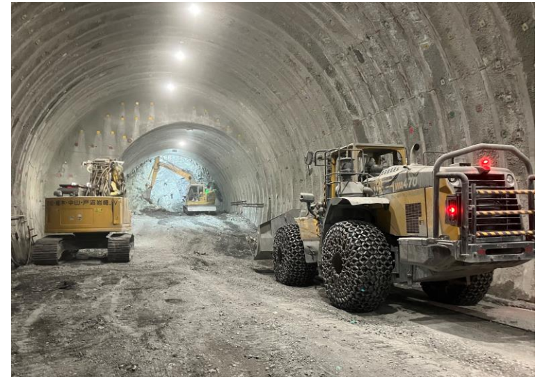
渡島トンネル(台場山) トンネル掘削状況
