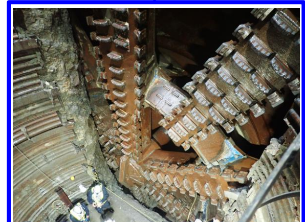
中間立坑でのシールドマシンの到達状況
