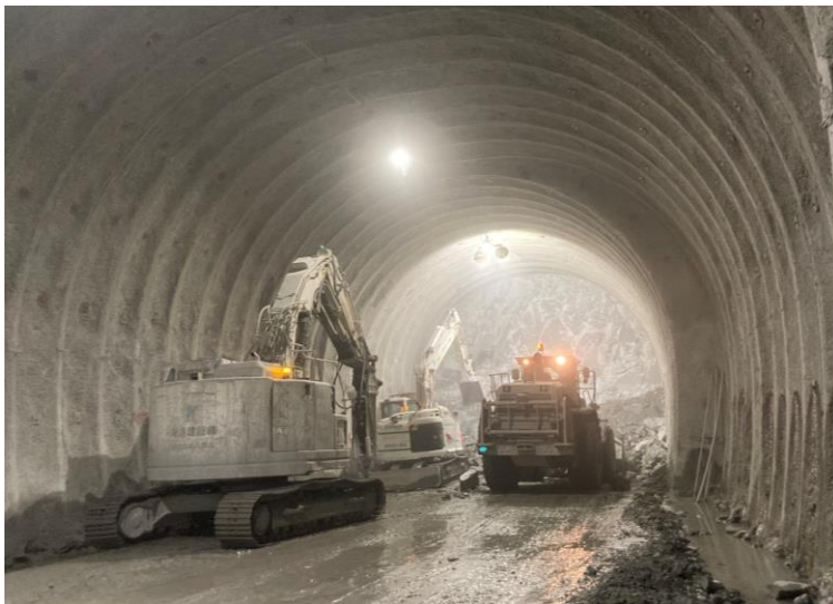
渡島トンネル(南鶉) トンネル掘削状況
