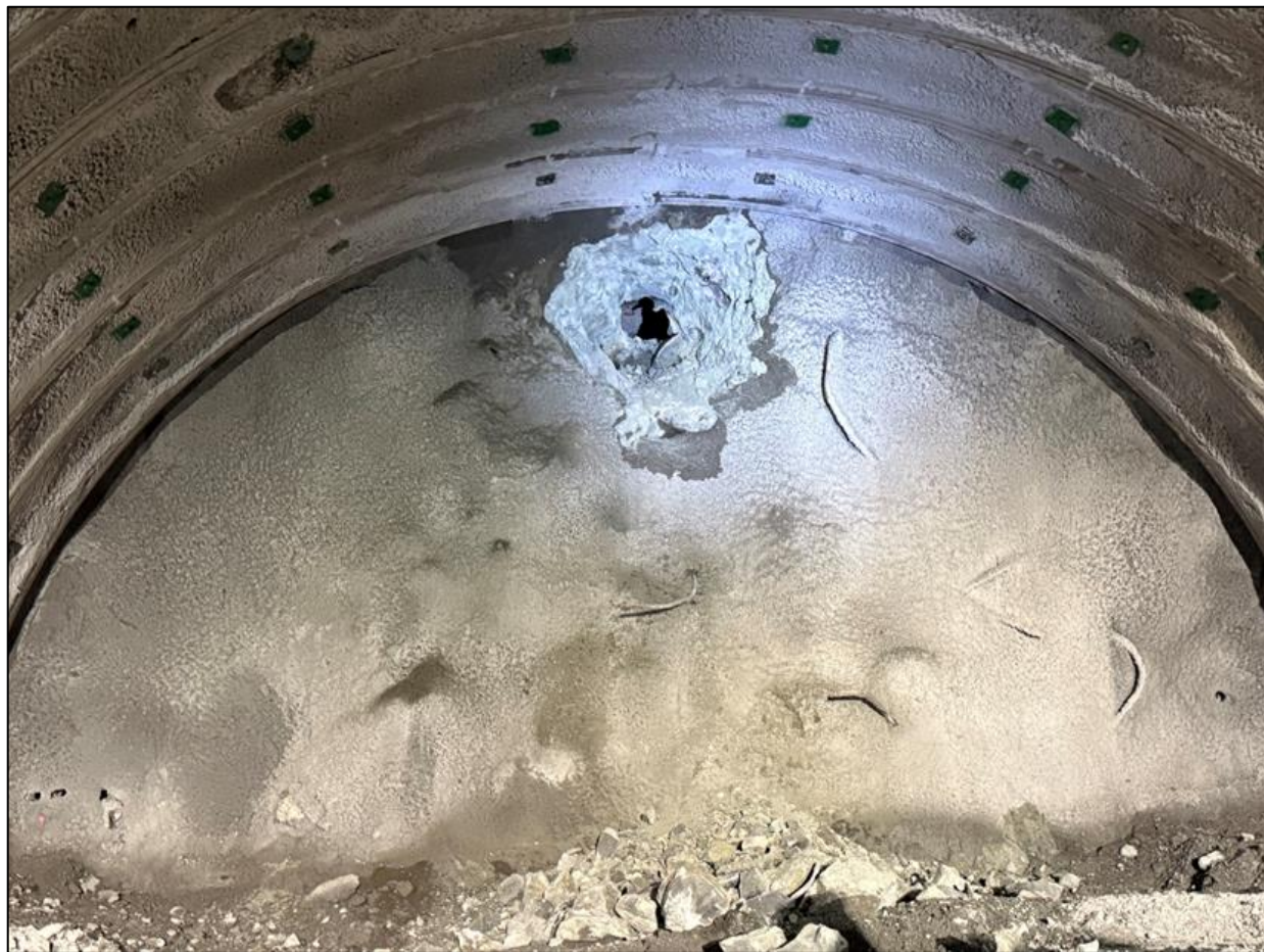
掘削完了地点の状況
