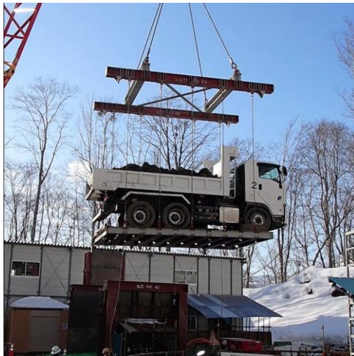
発生土搬出状況(到達立坑部(地上部))
