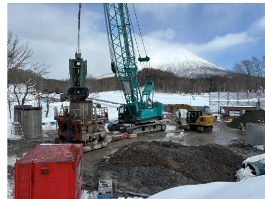
岩塊撤去状況
