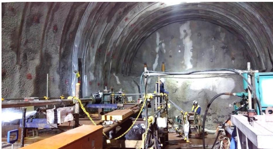
北鶉工区からの長尺ボーリング実施状況
