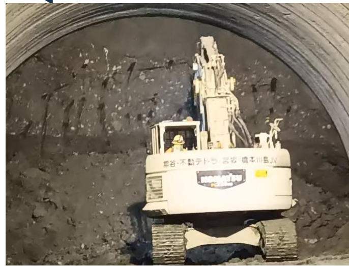
NATM掘削状況
