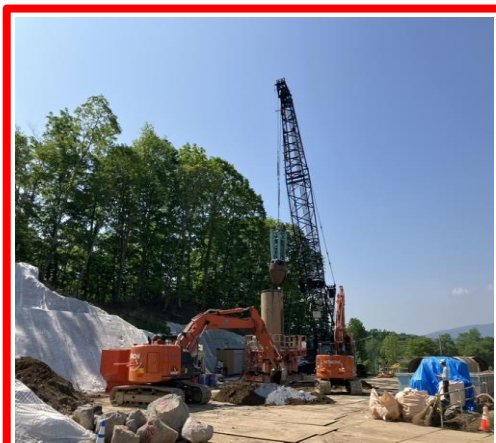
岩塊撤去状況
