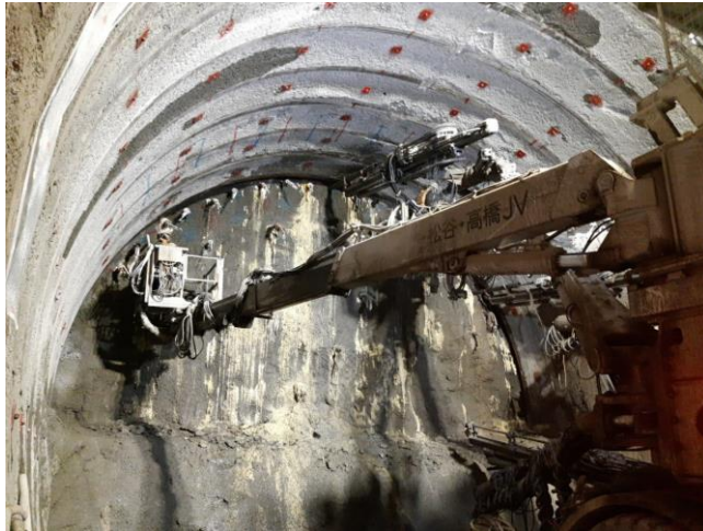
札幌トンネル(富丘) トンネル掘削状況
