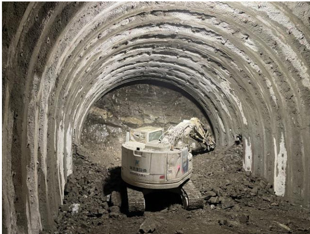
渡島トンネル(南鶴) トンネル掘削状況
