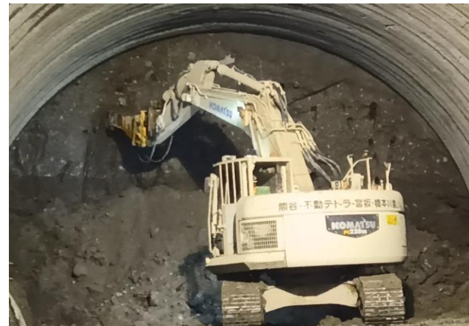
NATM掘削状況
