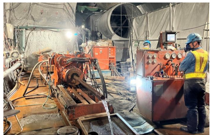
台場山工区から札幌方への長尺ボーリング実施状況
