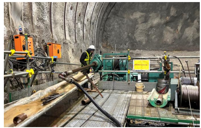
天狗工区から新函館北斗方への長尺ボーリング実施状況
