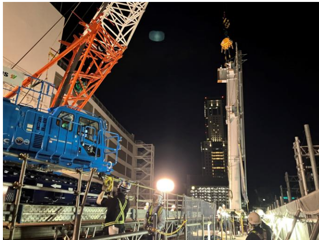
鉄骨建方工事の様子
