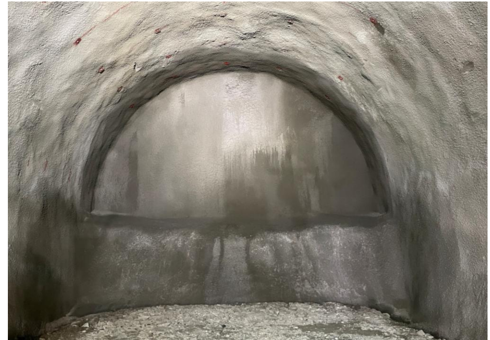
掘削完了地点の状況
