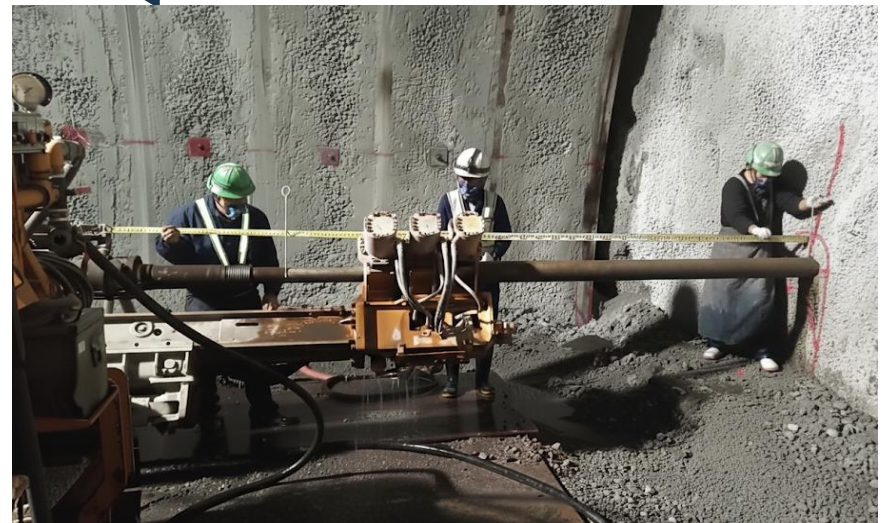
水平ボーリング実施状況
