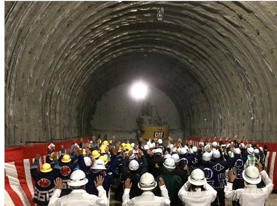
掘削完了地点の状況
