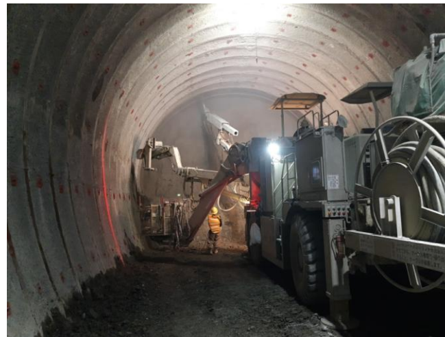
札幌トンネル(富丘) 掘削補助工施工状況
