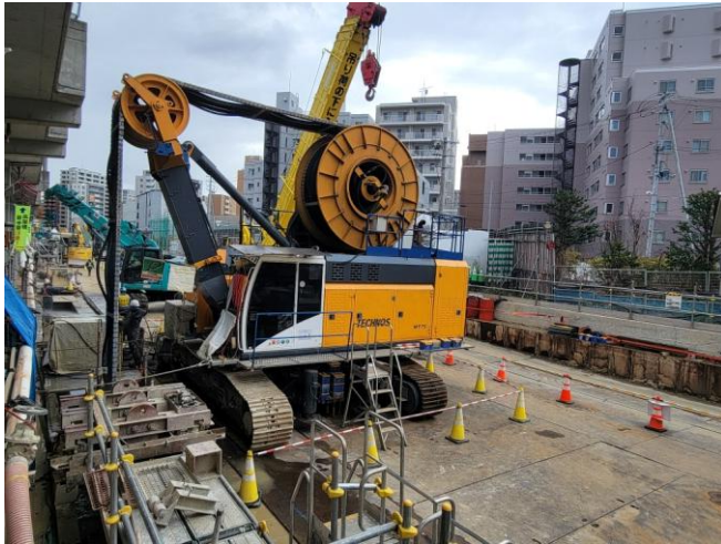
札幌トンネル(桑園) 鋼製連壁掘削状況
