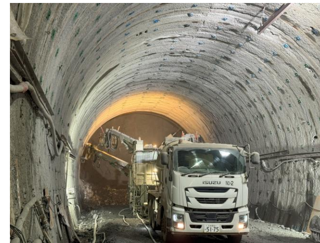
札幌トンネル(石倉) 吹付コンクリート施工状況
