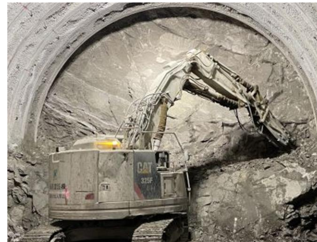
渡島トンネル(南鶉) トンネル掘削工施工状況
