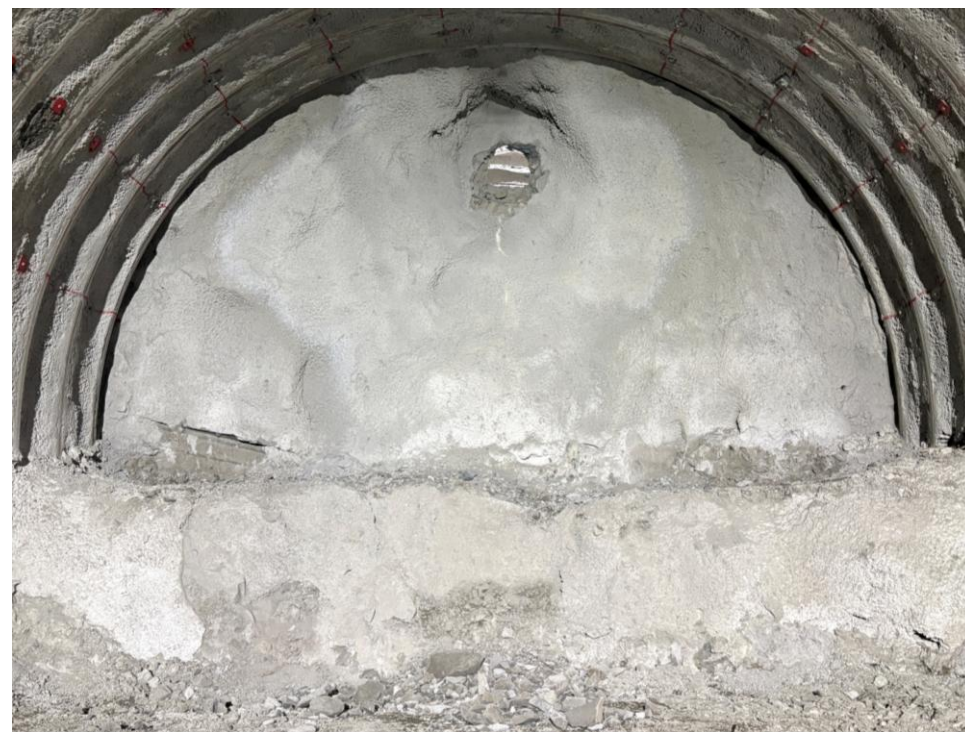
掘削完了地点の状況
