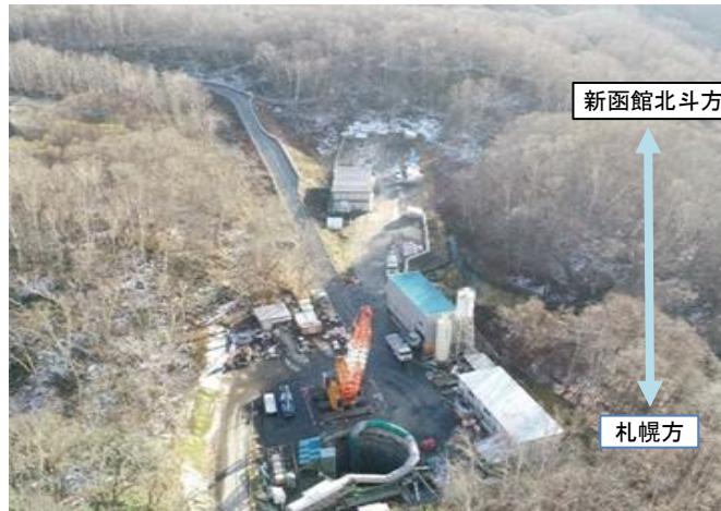
到達立坑ヤード全景
