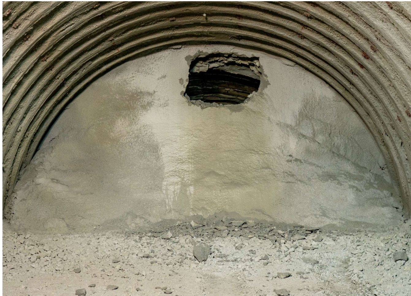
掘削完了地点の状況
