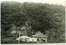
道内初の水力発電所（岩内町）
