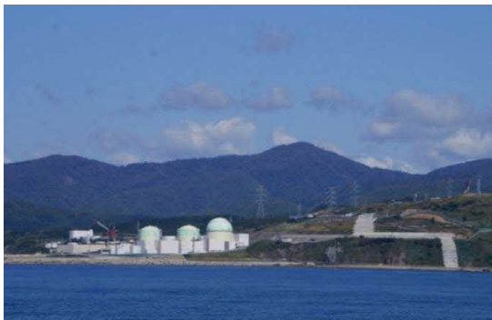
泊発電所全景
