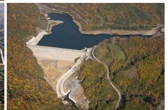
京極ダム全景
