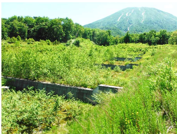
羊蹄山麓における治山ダム
