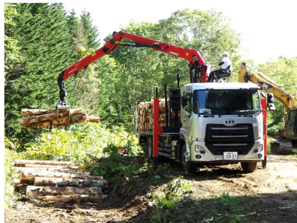
運材車積み込み状況
