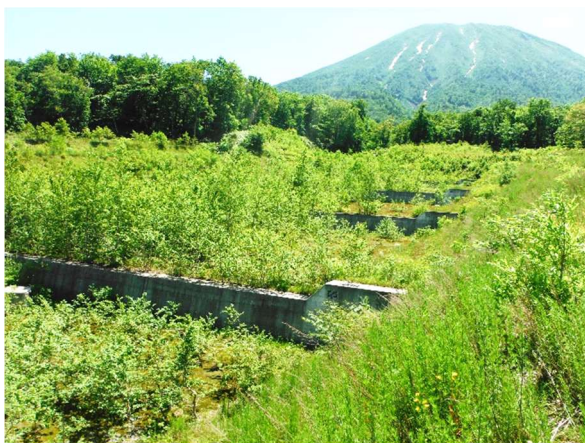
羊蹄山麓における治山ダム
