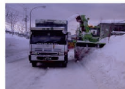
運搬排雪状況
