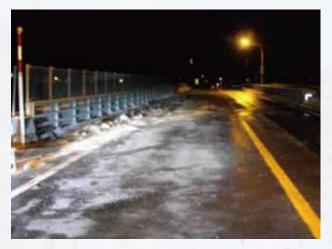
橋梁の手前は乾燥していますが、橋梁上が 凍結しています。
